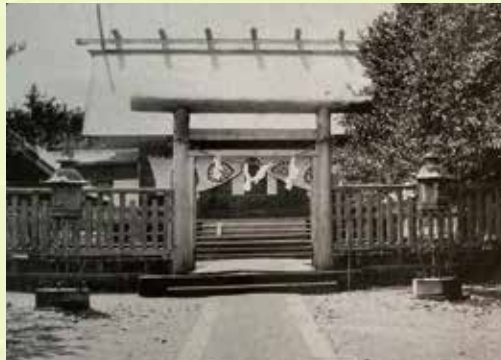
拝殿正面【明治11年造営】
