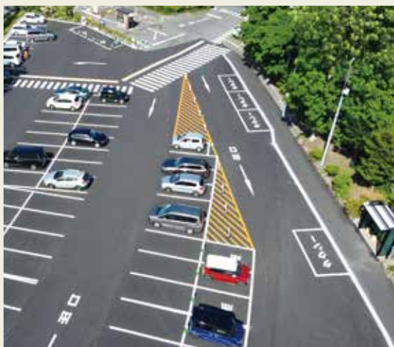
北一条駐車場舗装工事
