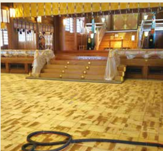
拝殿床修繕工事
